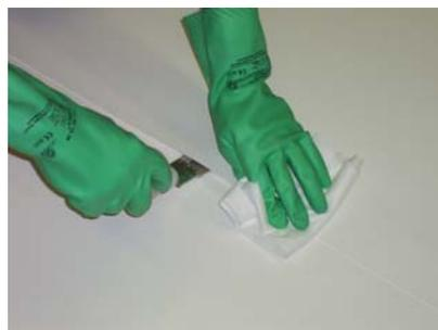
L'emploi du solvant est subordonné au respect des consignes d'hygiène et de sécurité du travail, en conformité au mémento de formation aux « Étanchéités à base de monocouche synthétique » édité par la CSFE. La soudure au solvant n'est pas admise sur polystyrène expansé.
